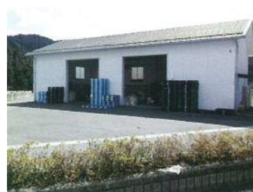
ストックヤード施設
