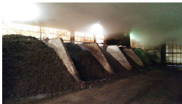
(写真1) 堆肥化施設内
