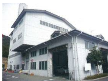
ごみ焼却処理施設
